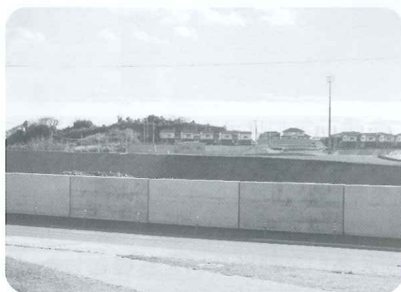
整備中の防潮堤(奥は災害公営住宅)
