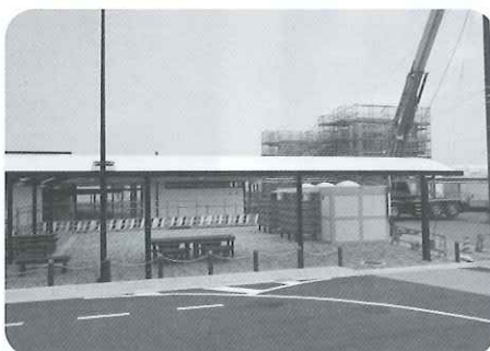
【建設中の富岡駅】
